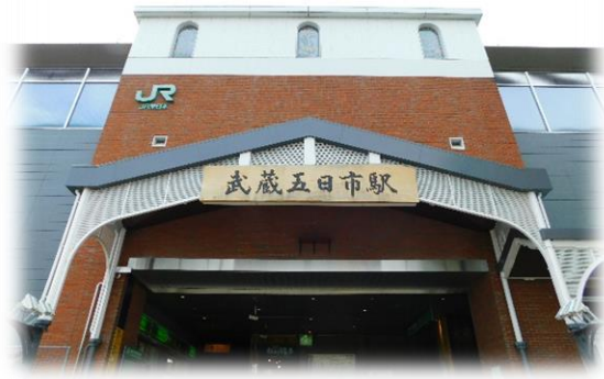
↑ レンガ基調で落ち着いた外装の武蔵五日市駅
